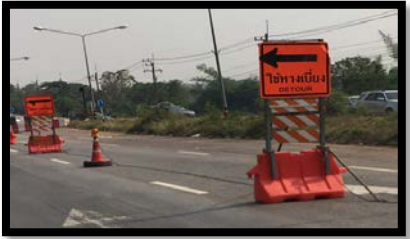
1. ทล.2 ตอน บ.ห้วยหินลาด-อ.โนนสะอาด กม.377+000
