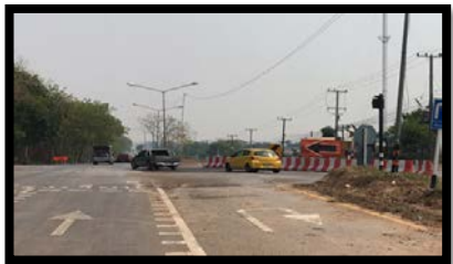
3. ทล.2 ตอน บ.ห้วยหินลาด-อ.โนนสะอาด กม.394+700
